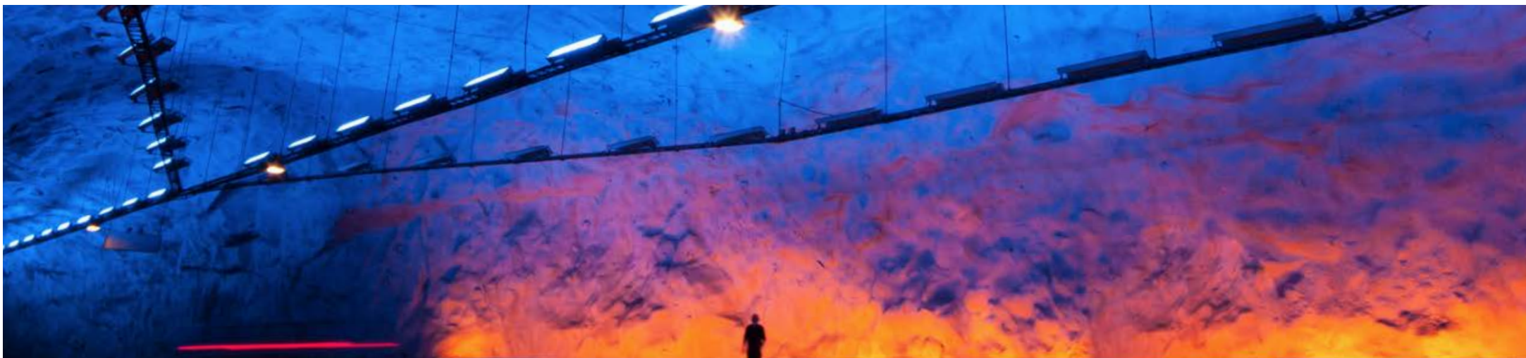
FJELLHALL MED NORDLYS-PROJEKSJON I TAK
